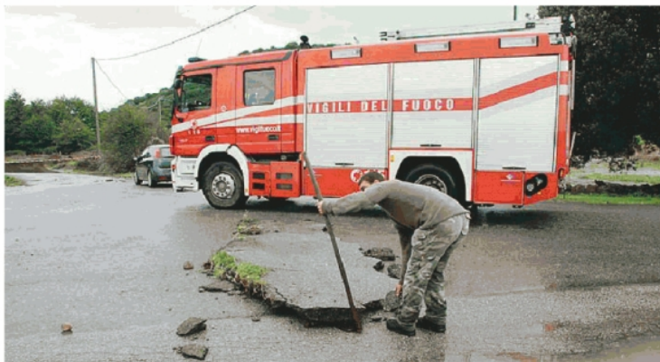
I vigili del fuoco in trincea per contenere i danni provocati in città dal ciclone Cleopatra
