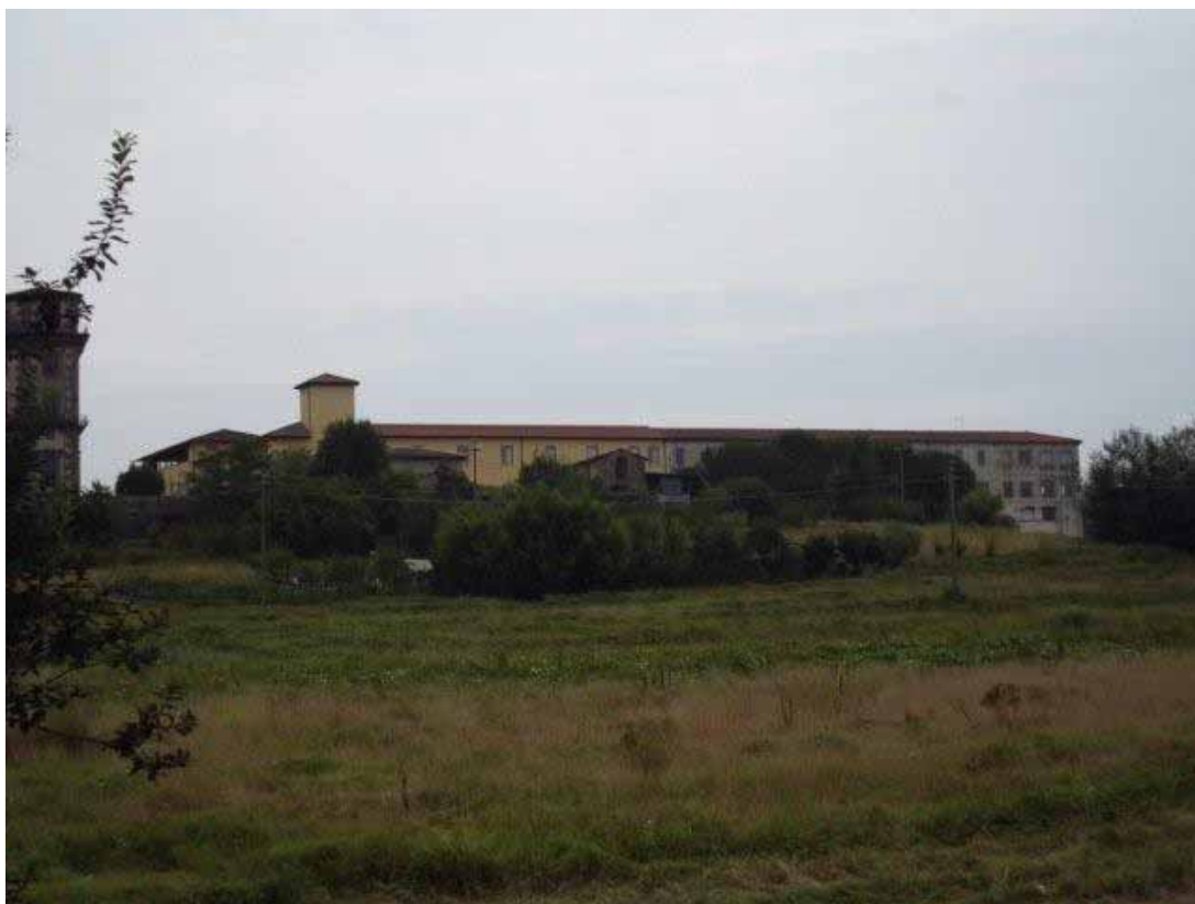
Figura 40: IL RETRO DEL VECCHIO CONVITTO, POI SCUOLA, EX “FATTORIA GENTILIZIA”. L’EDIFICIO CHE IL CONAPO CHIEDE DI NON LASCIARE IN ABBANDONO E UTILIZZARE QUALE CASA DI RIPOSO PER VIGILI DEL FUOCO IN PENSIONE, MAGARI CON CONVENZIONI ASL. LA PARTE A SINISTRA, CON FACCIATA IN GIALLO, E’ STATA DA TEMPO RISTRUTTURATA CON INGENTE SPESA DI DENARO MA NONOSTANTE CIO’ RIMANE CHIUSA DAL 2009 IN ATTESA DI UN FANTOMATICO COLLAUDO.
