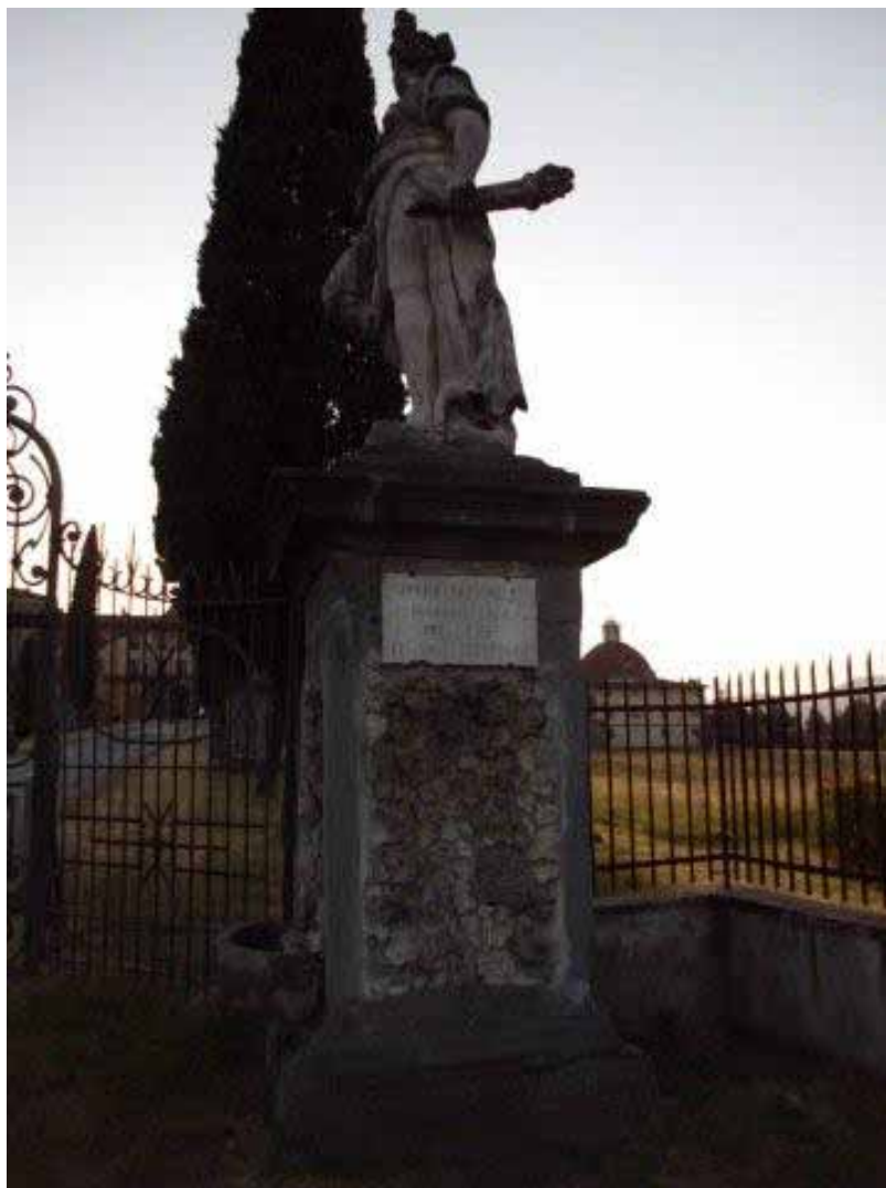
Figura 9: PILASRTO DEL CANCELLO D'INGRESSO PRINCIPALE OVE E' FISSATA LA TARGA DELL' ONA.
