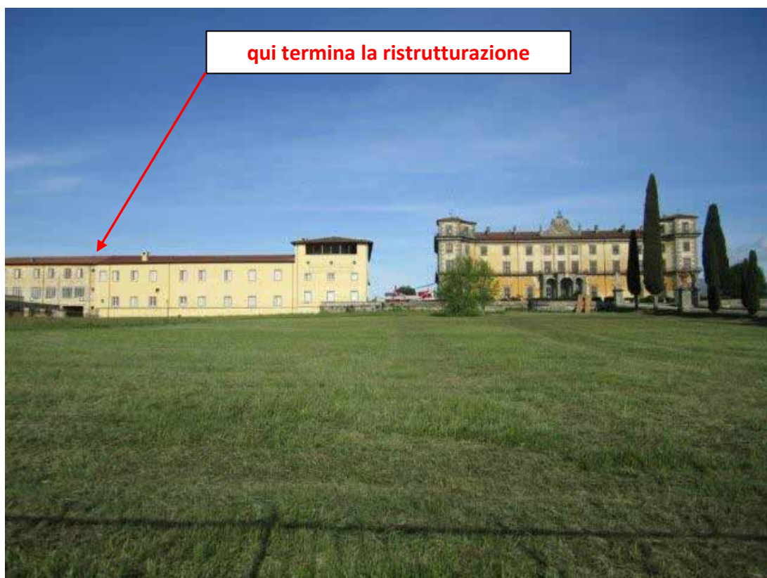
Figura 11: SULLA DESTRA LA "VILLA BELLAVISTA" E SULLA SINISTRA LA EX "FATTORIA MEDICEA" ANCH' ESSA DI PROPRIETA' DELL' ONA E RISTRUTTURATA PER LA PARTE IN GIALLO, MA AD OGGI NON UTILIZZATA POICHE' DAL 2009 SI ATTENDE IL COLLAUDO.
