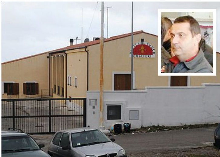
La caserma dei vigili del fuoco di Cuglieri. Nel riquadro, Gianni Senes
