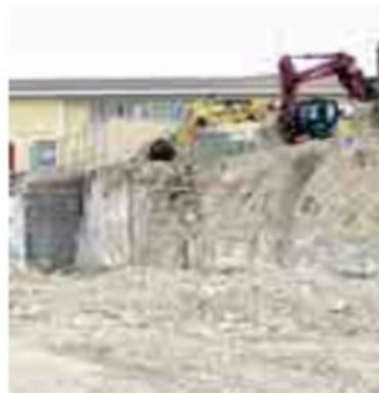
Sisma, la caserma demolita
