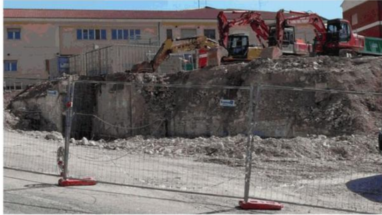
La caserma dei vigili del fuoco dell'Aquila nel corso delle demolizioni
