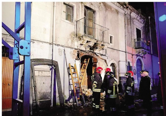
La palazzina dove si è verificata l'esplosione, nel centro storico di Catania FOTO ANSA
