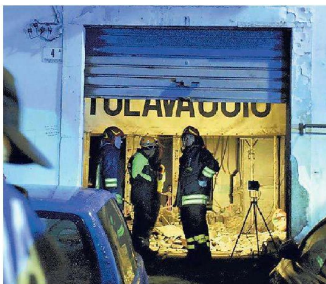
Vigili del fuoco sul luogo dell'esplosione nel centro di Catania
