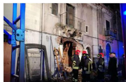
L'edificio danneggiato dall'esplosione, per una fuga di gas
