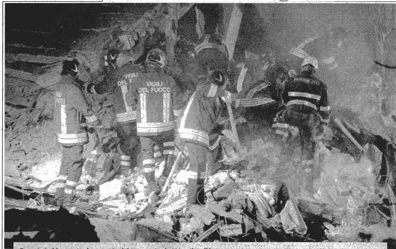
Pompieri al lavoro tra le macerie del terremoto de L'Aquila. Olycom
