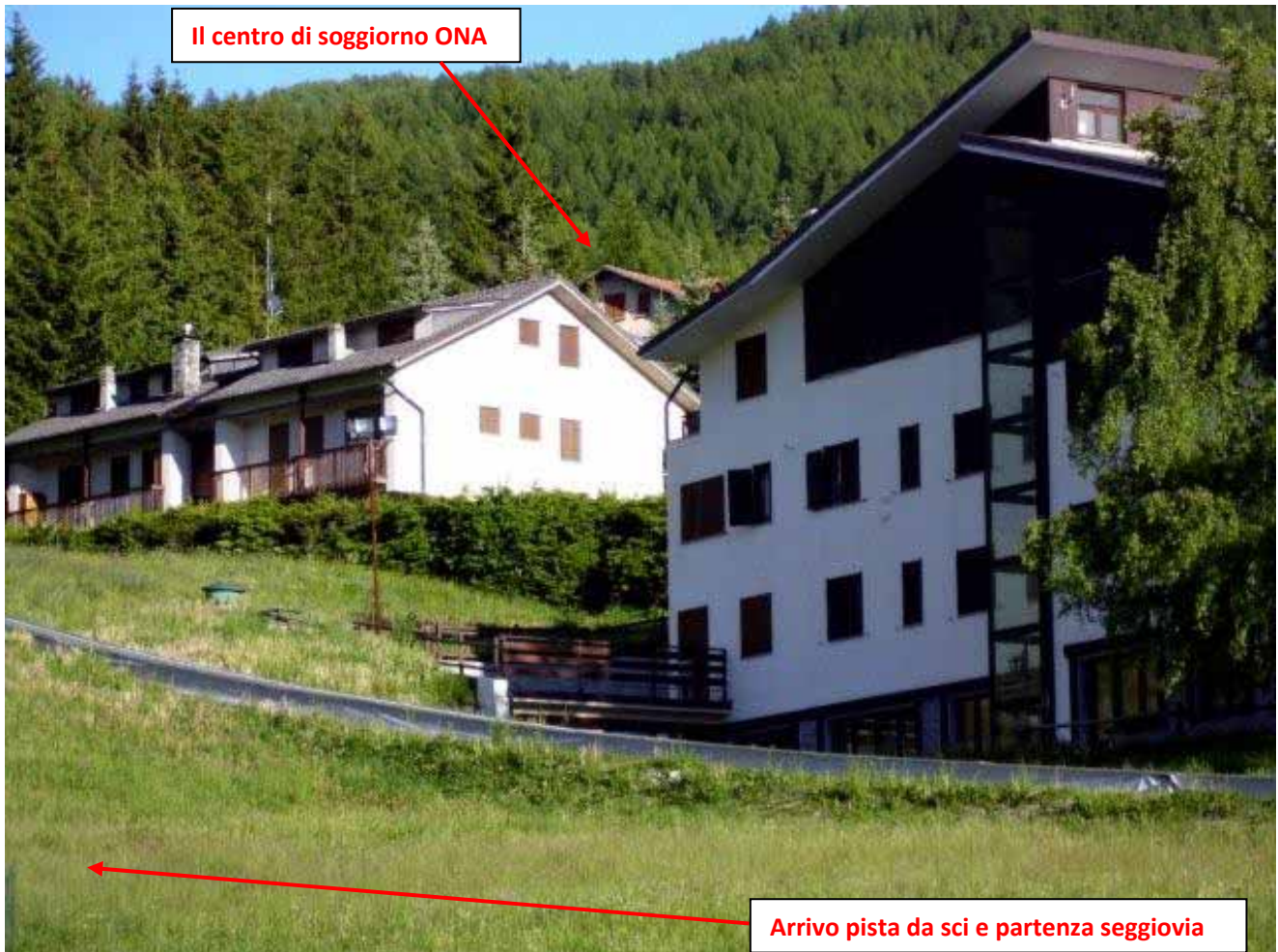
Figura 17: IL CENTRO ONA VISTO DA BORDO PISTA.
