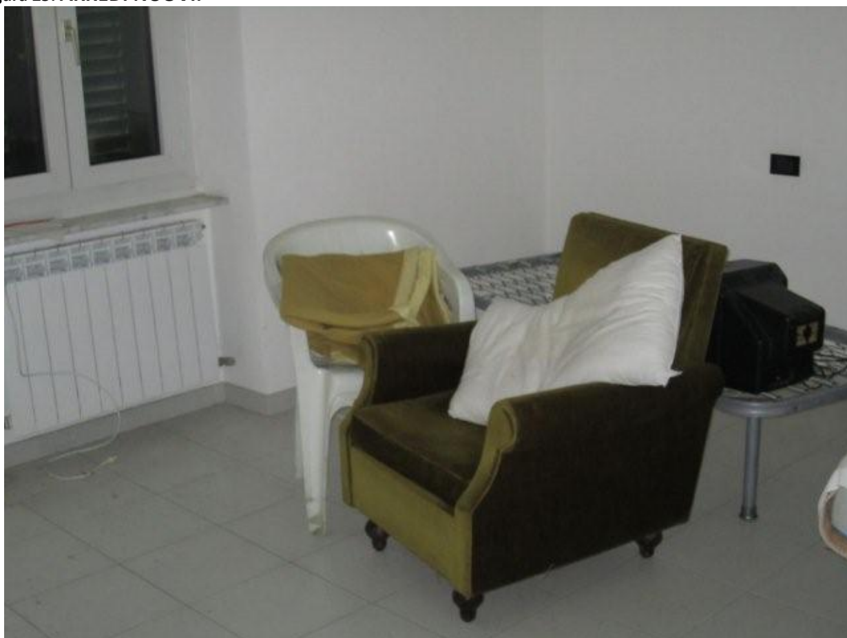
Figura 26: ARREDI NUOVI, TERMOSIFONI NUOVI E NELLO SFONDO INFISSI NUOVI.
