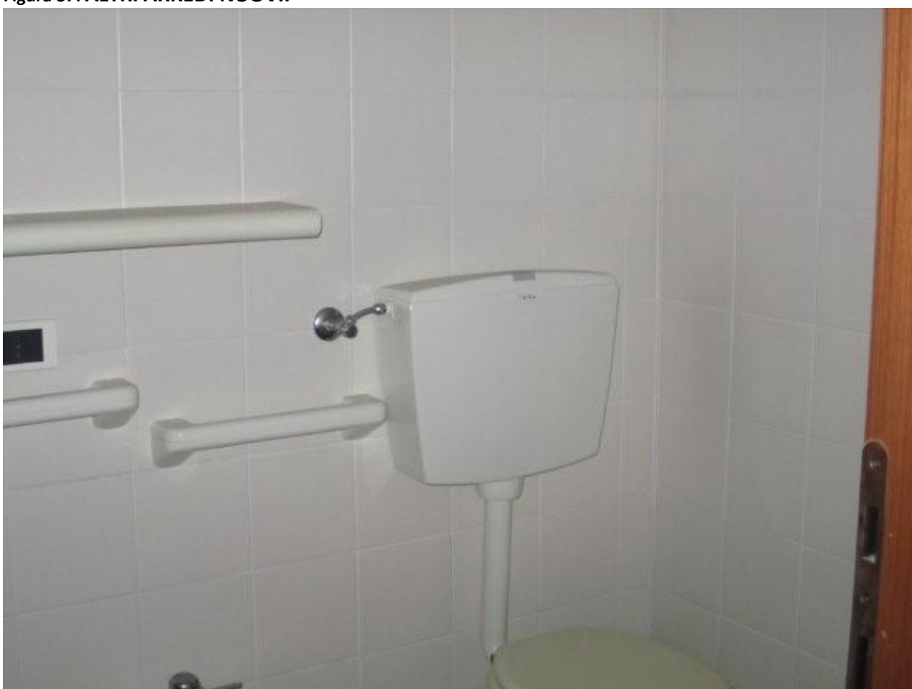
Figura 38: BAGNI NUOVI, RIVESTIMENTI NUOVI, CON SANITARI NUOVI.
