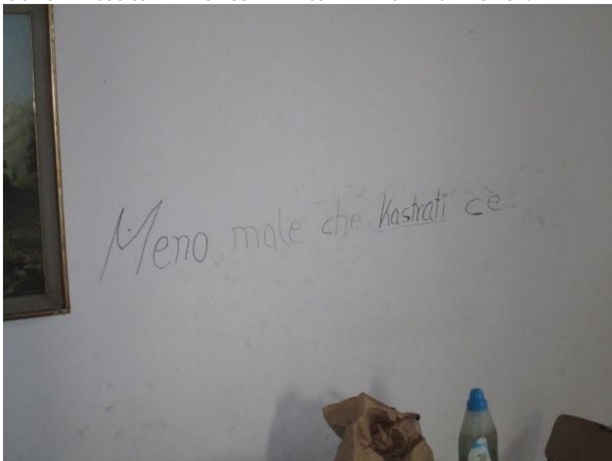
Figura 20: FOTO DI COME E' TRATTATO L'IMMOBILE ALL'INTERNO.
