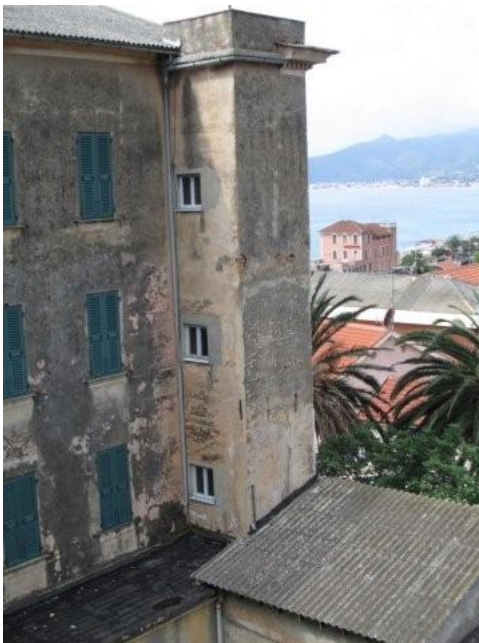
Figura 69: TETTO IN ETERNIT E INFISSI ESTERNI NUOVI.
