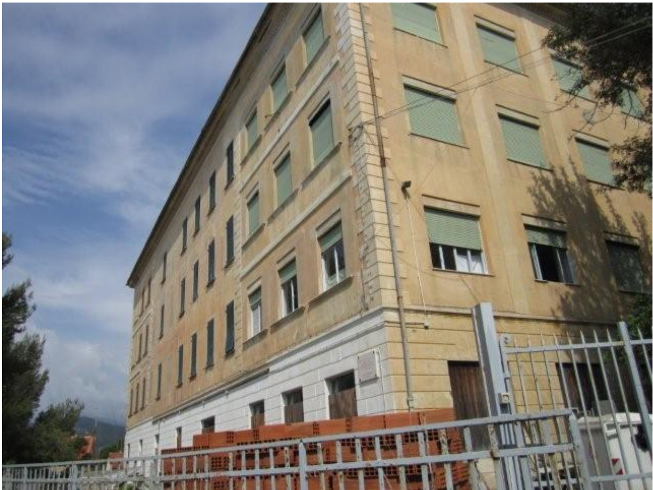
Figura 15: MATTONI SUFFICIENTI PER MURARE LE PORTE E IMPEDIRE TEMPORANEAMENTE L'ACCESSO AL CENTRO SINO ALLA RISTRUTTURAZIONE- PERCHE' SONO STATI PORTATI LI E NON UTILIZZATI ?
