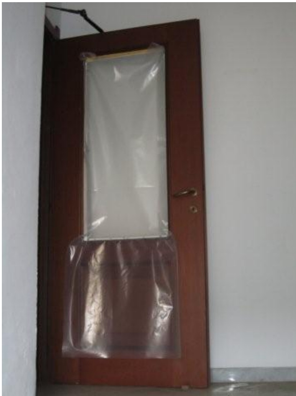
Figura 22: PORTE INTERNE ANCORA NUOVE, PROBABILMENTE ACQUISTATE E MONTATE PRIMA DELLA CHIUSURA DEL CENTRO
