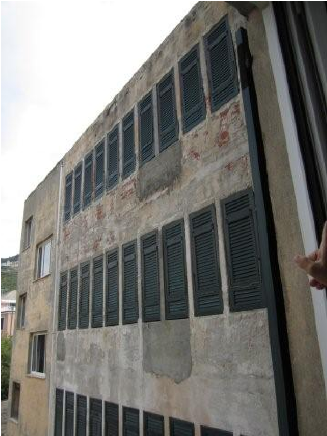
Figura 76: ALTRO LATO SEMPRE CON INFISSI NUOVI.
