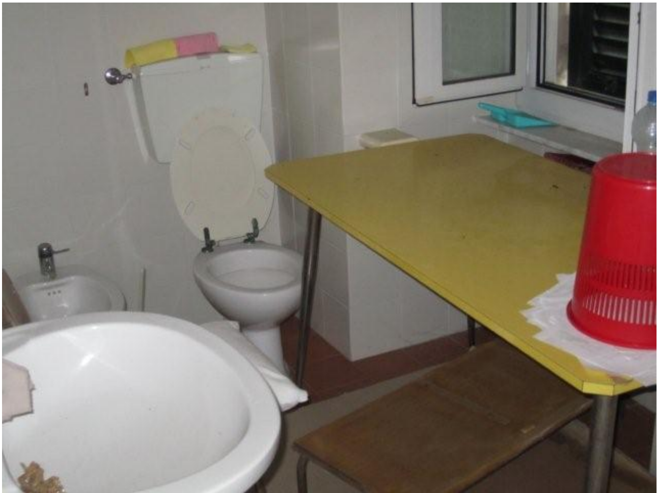
Figura 27: BAGNI E SANITARI NUOVI.
