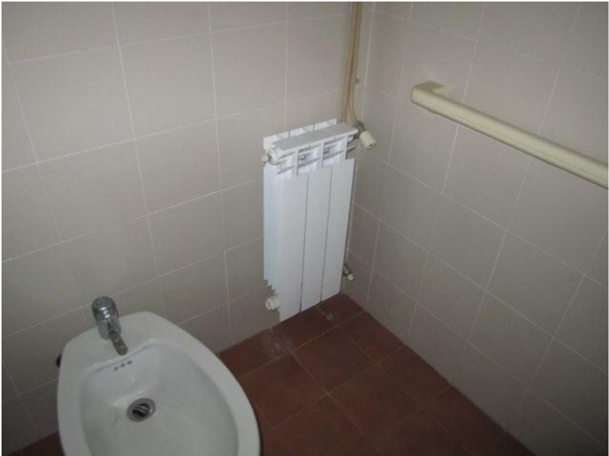
Figura 60: RIFINITURE E RISCALDAMENTI, NUOVI CHE EVIDENZIANO IL LAVORI E LE RISTRUTTURAZIONI FATTE POCO PRIMA DI CHIUDERE – L' ONA RENDA PUBBLICO QUANTO HA SPESO !
