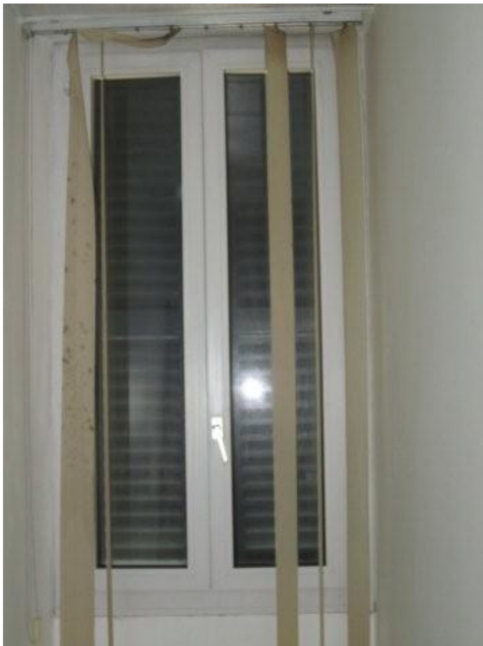
Figura 58: INFISSI NUOVI A VETROCAMERA.
