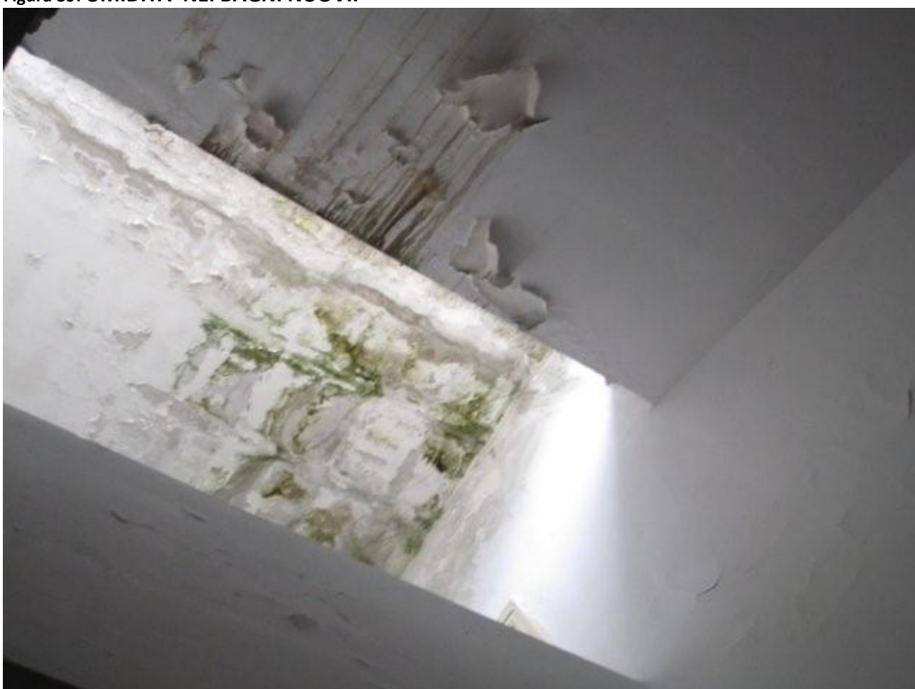
Figura 40: ALTRE FOTO DI SOFFITTI.
