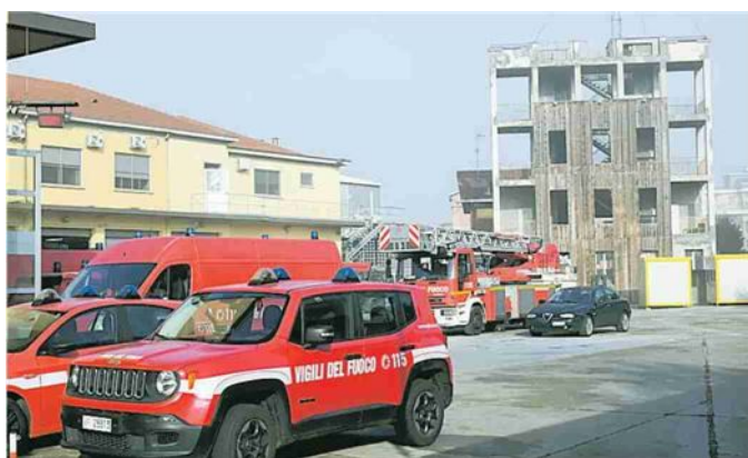
L'attuale sede della caserma dei vigili del fuoco in viale Campari
