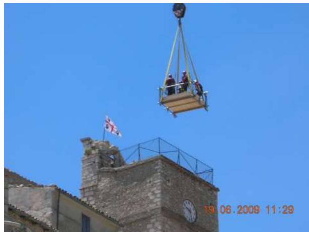
Personale SAF in cestello autoprodotta (vedi TEC-CST) vincolato direttamente al gancio della gru mediante corda di lavoro e corda di sicura
