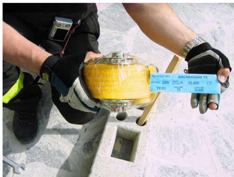
Fasce in poliestere impiegate per la tirantatura.
